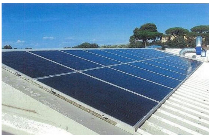
Esempio tipologico di applicazione su copertura metallica
